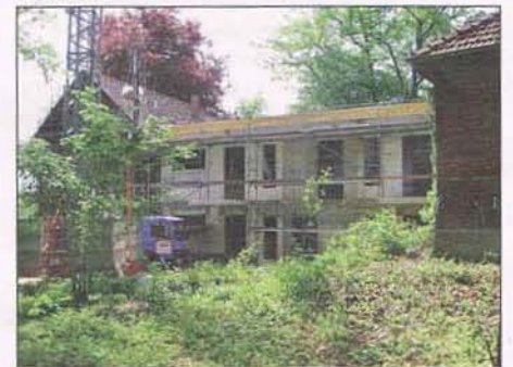
Der Rohbau des Hospizgebäudes steht.
