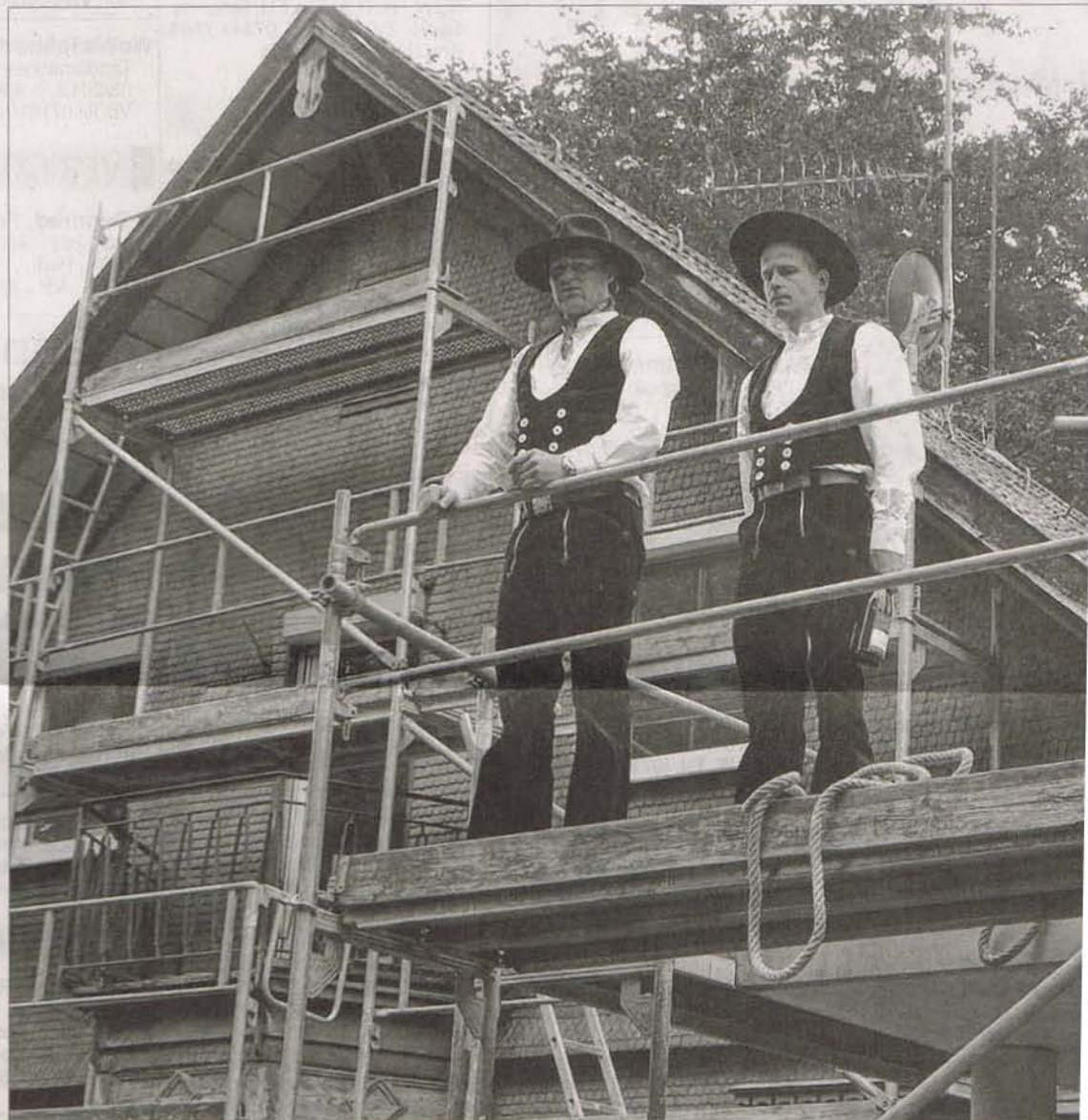
Die Zimmerleute bestiegen für den Richtspruch das Gerüst am denkmalgeschützten Altbau der Villa Hammer. Gefeierte das Richtfest am angrenzenden Neubau des Hospizhauses. Foto: Sylvia
